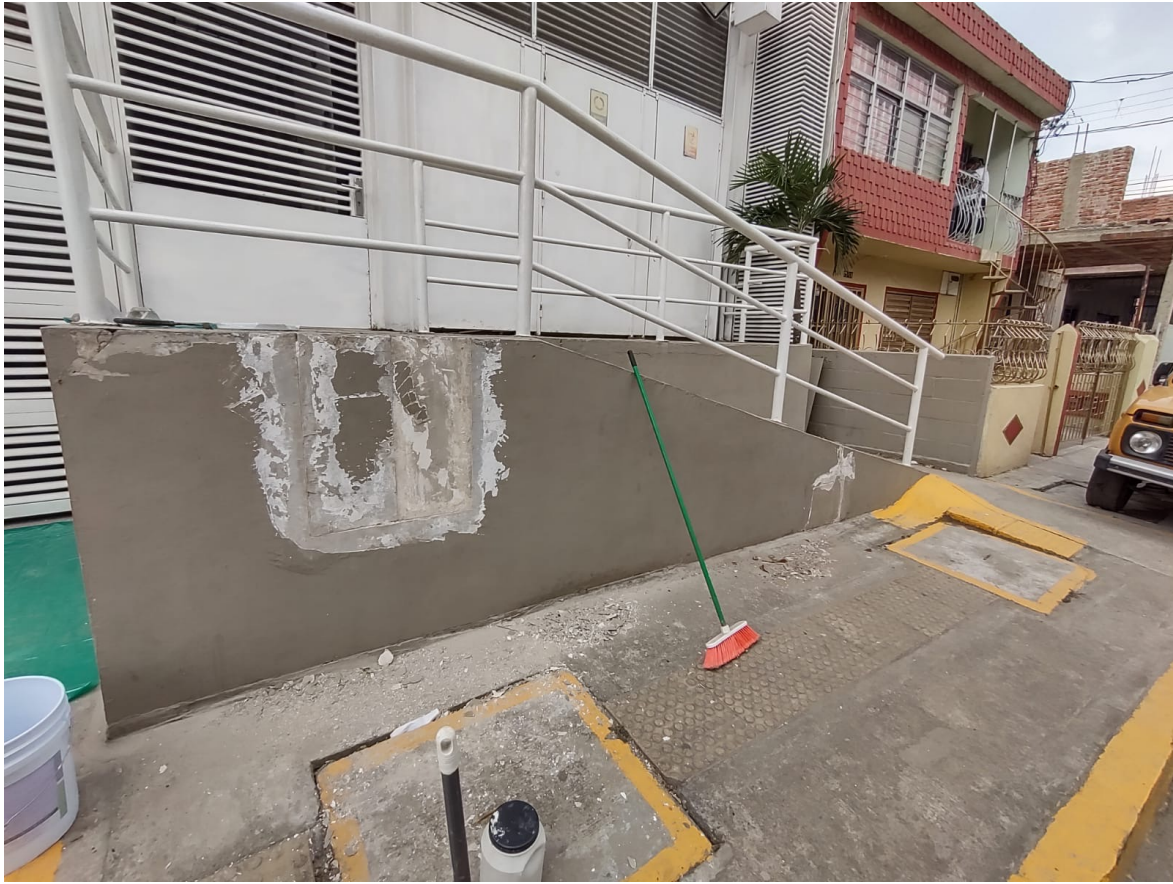
CAMBIO DE MATERIAL UTILIZADO A GRANIPLAST PARA MAYOR DURACIÓN
